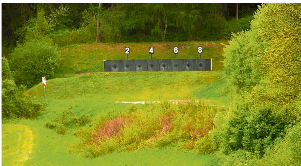
In den letzten Jahrzehnten wurde die Schiessanlage in Domat/Ems fortlaufend umgebaut und modernisiert und ist damit bestens für Grossanlässe gerüstet. Bilder zVg
